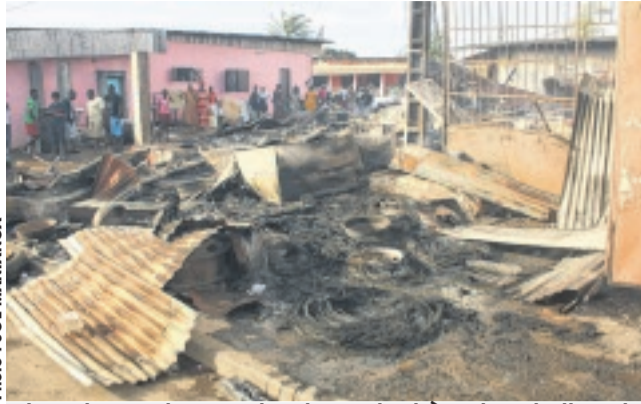
Les cinq maisons qui se trouvaient à cet endroit sont toutes parties en fumée.
