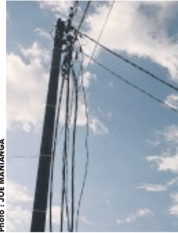
Le poteau électrique objet de piratage par des usagers.
