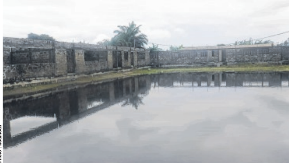
... dont la cour s'inonde en période pluvieuse.
