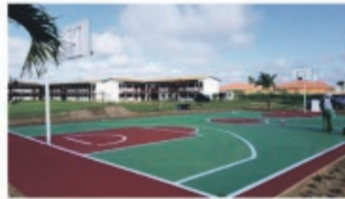
Dernières finitions au niveau du Plateau Sportif
