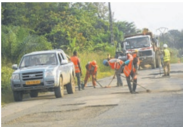
Les crevasses à l'origine de l'accident.
