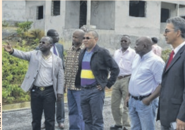
Ici, l'ancien DG de la SNI, Juste-Valère Okologo faisant visiter un chantier qui, finalement n'aboutira jamais.
