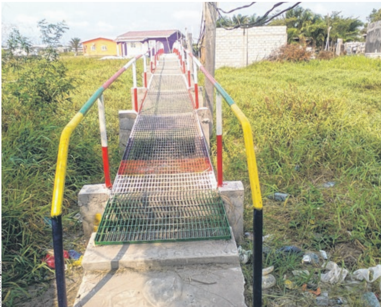
L'une des passerelles construites par le parlementaire dans un quartier à Port-Gentil.
