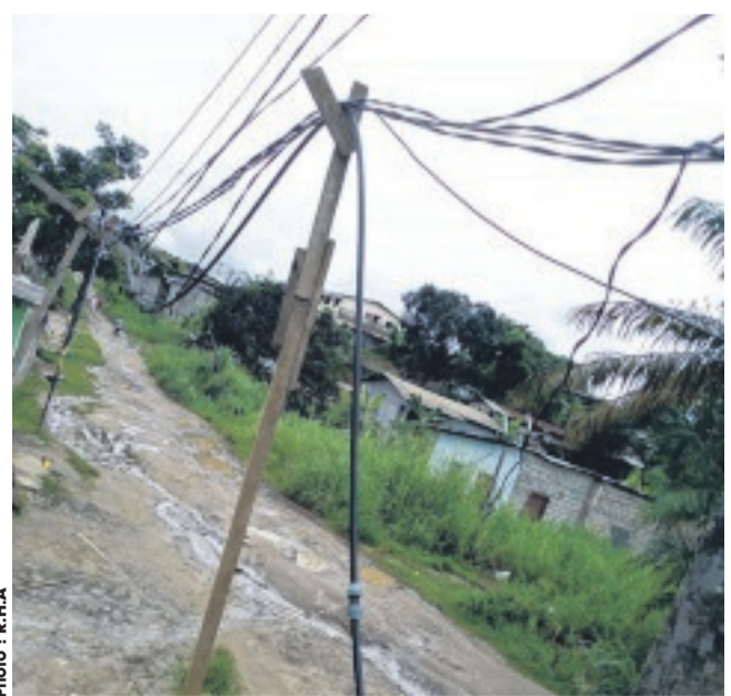
Ces supports non conventionnels permettent à la fois d'amener les conduites d'eau et les fils électriques vers les habitations.
