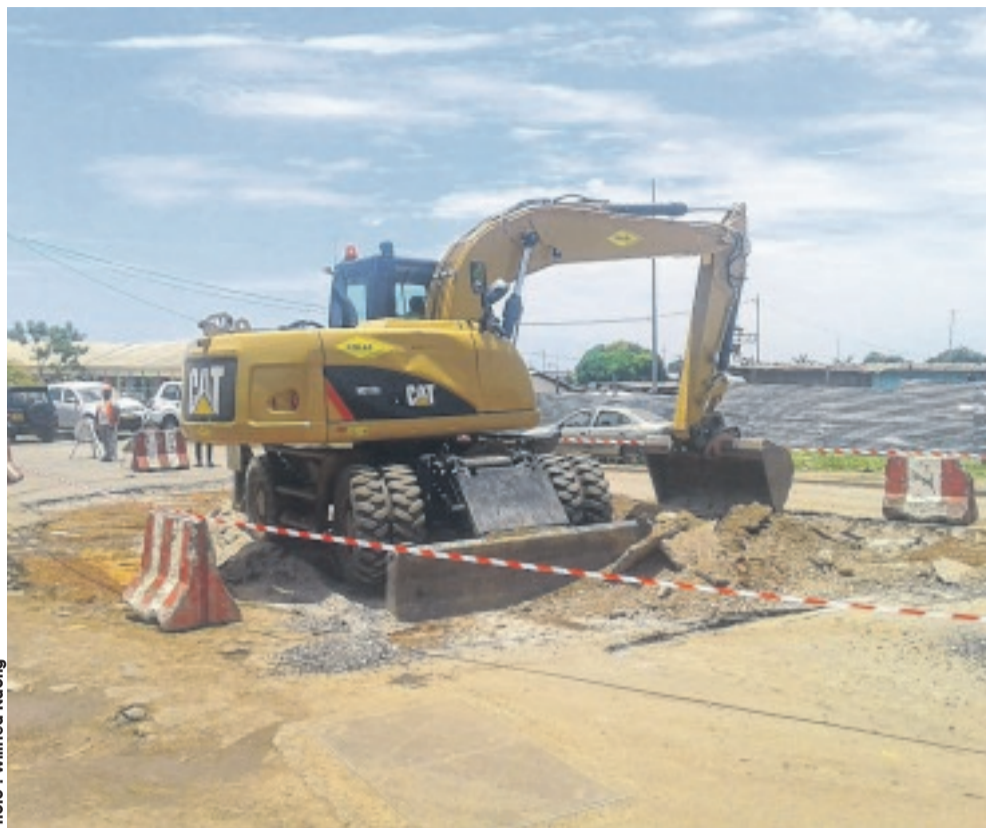
Non loin de l'Institut africain d'informatique, les travaux débutent timidement...
