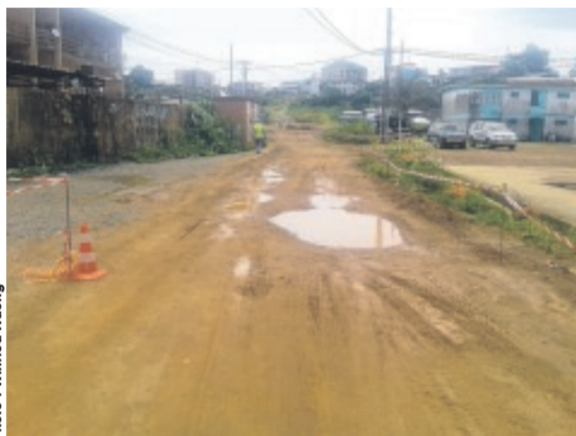
Le chantier de la "bretelle" Camp de police-Montagne sainte piétine.
