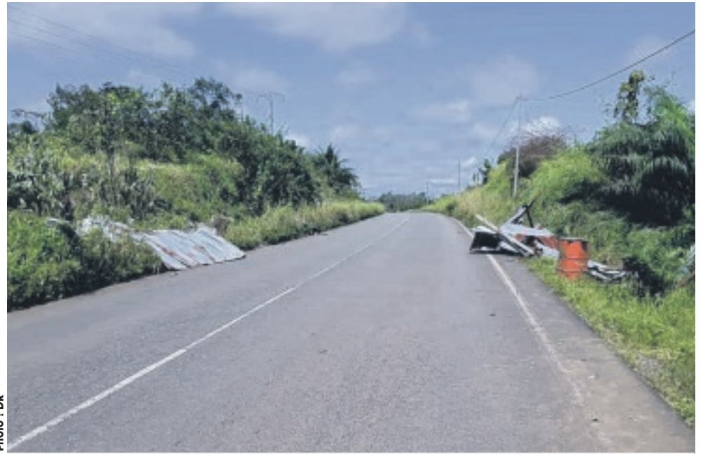
Certaines toitures ont échoué sur le bitume.
