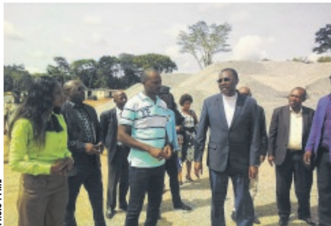
Joël Ogouma et sa suite sur le chantier de Ferreira.
