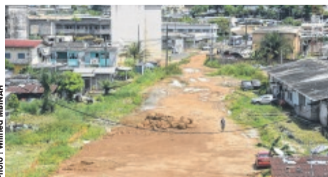
Voilà dans quel état se trouve toujours le chantier de la "bretelle" camp de police-Montagne sainte.
