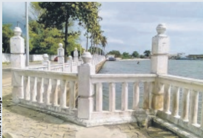
La barrière de protection du front de mer.
