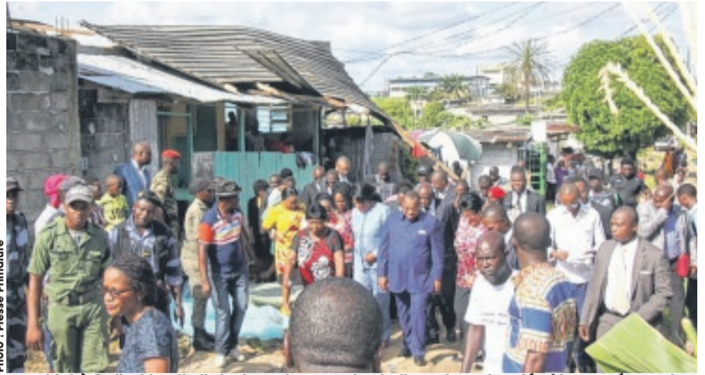
...et ici à Belle-Vue II, il s'est rendu compte de l'ampleur des dégâts causés par la pluie de jeudi dernier.
