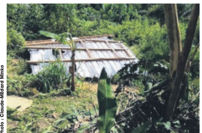
La toiture qui couvrait l'édifice.
