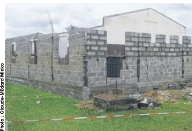
... les murs du nouveau centre médical de Moanda sont sortis de terre.
