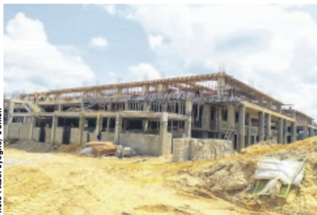
Le squelette du marché sort progressivement de terre.
