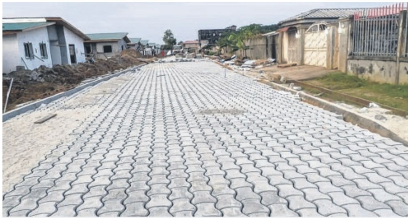
Toutes les voies de la cité Magnolia seront pavées.
