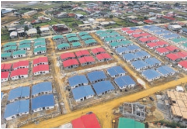
Vue aérienne du chantier de la cité Magnolia, exécuté à 85%.
