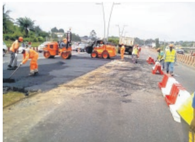
Les ouvriers de Colas étaient déjà hier à pied d'oeuvre pour lancer le chantier.
