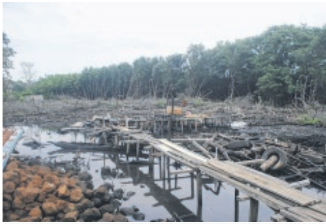
L'ANUTTC et la mairie de Libreville ont détruit les habitations construites sur des mangroves.
