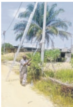
Un technicien de l'ONEE à l'ouvrage sur un des lampadaires de Bel-Air-Carrière.
