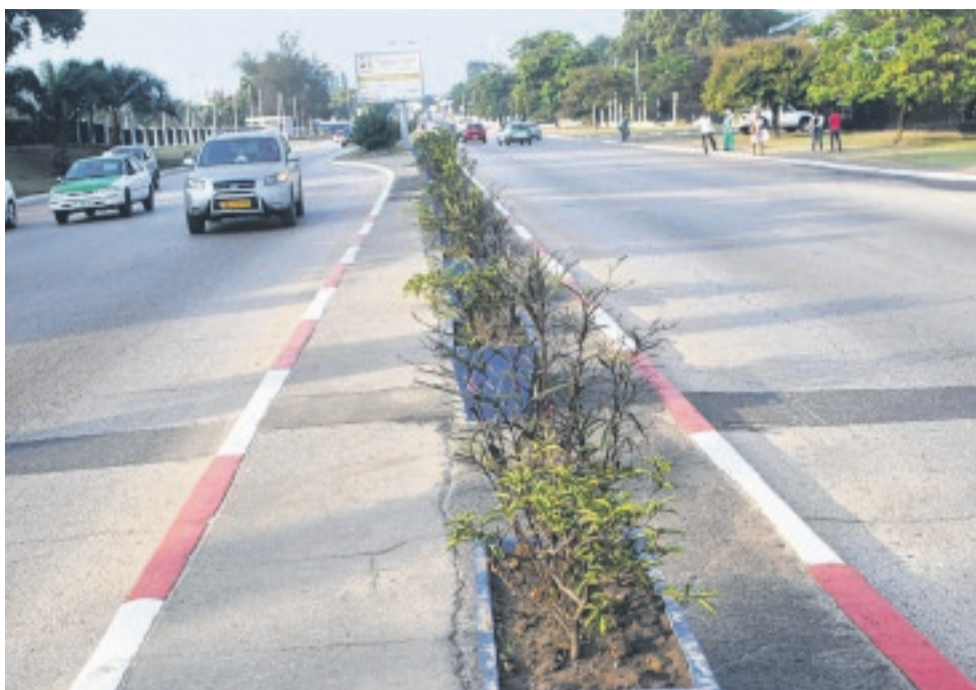
Le terre-plein central du boulevard Triomphal jalonné de bacs à fleurs, un risque accru à long terme pour les usagers.
