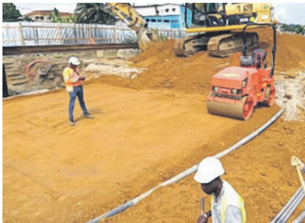
Les ouvriers mettent les bouchées doubles.
