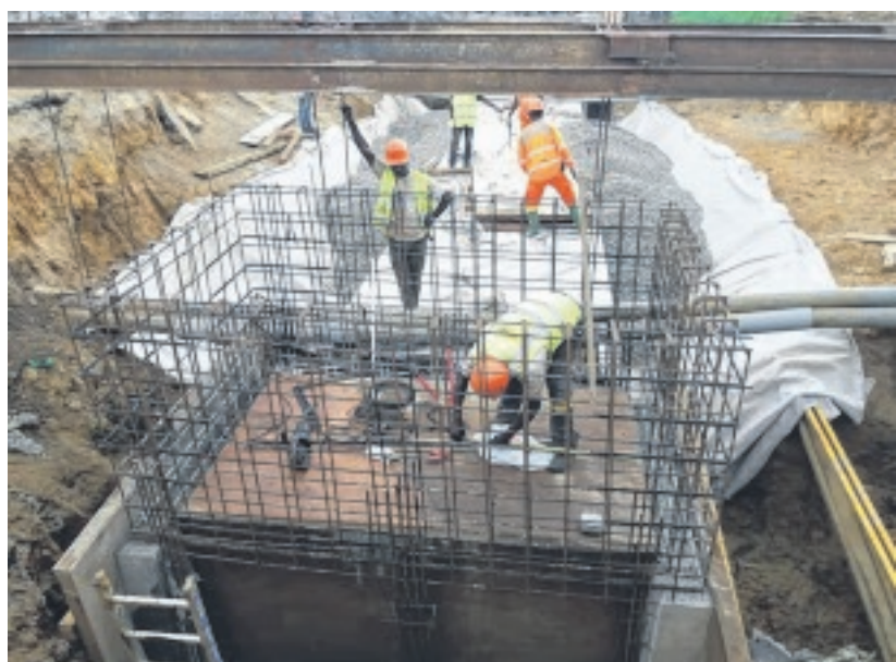
Les ouvrages connexes sont également réalisés pour garantir la solidité de l'ensemble.
