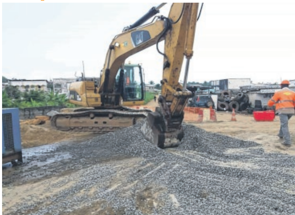
Des engins lourds sont à l'œuvre sur le chantier.
