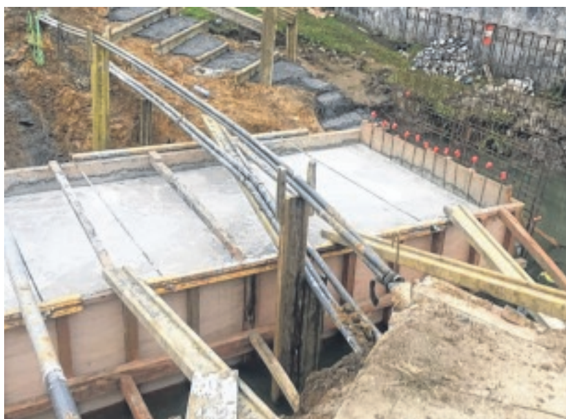
Le dalot dont la construction est en voie d'achèvement permettra de solidifier l'ouvrage.
