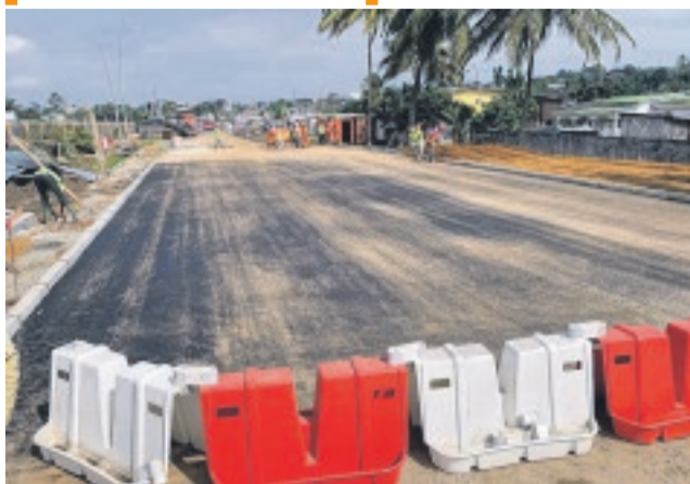
Cette couche de revêtement a déjà reçu le bitume.
