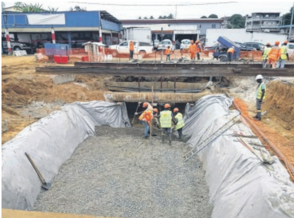
...la nouvelle buse va être posée dans quelques jours.
