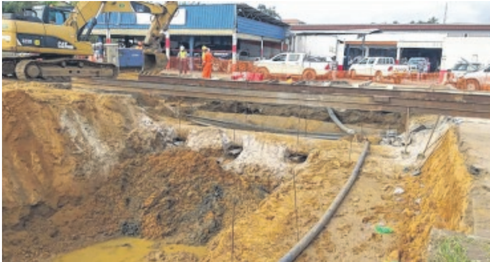
Après les travaux de fouilles de l'ancienne buse...
