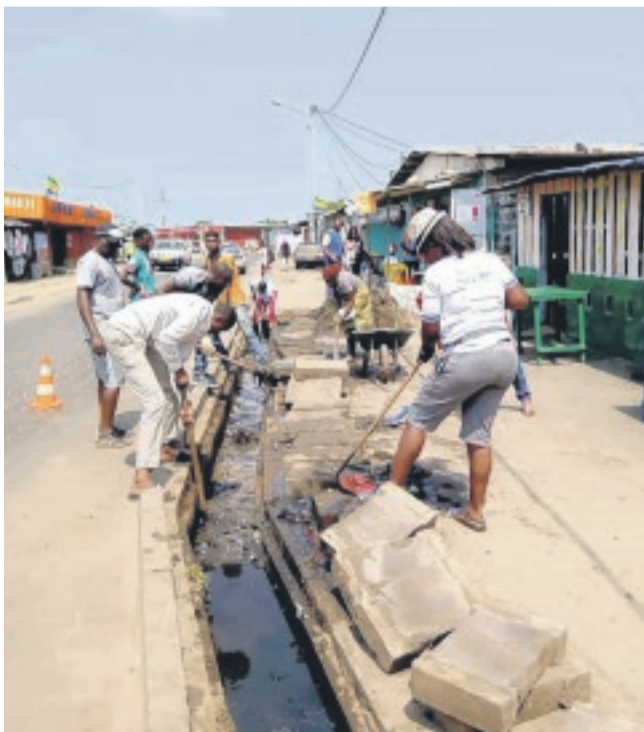
Curage d'un caniveau pendant l'opération
