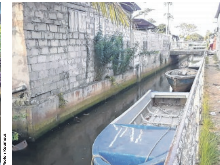
Ici, on a exploité le mur de ce canal.
