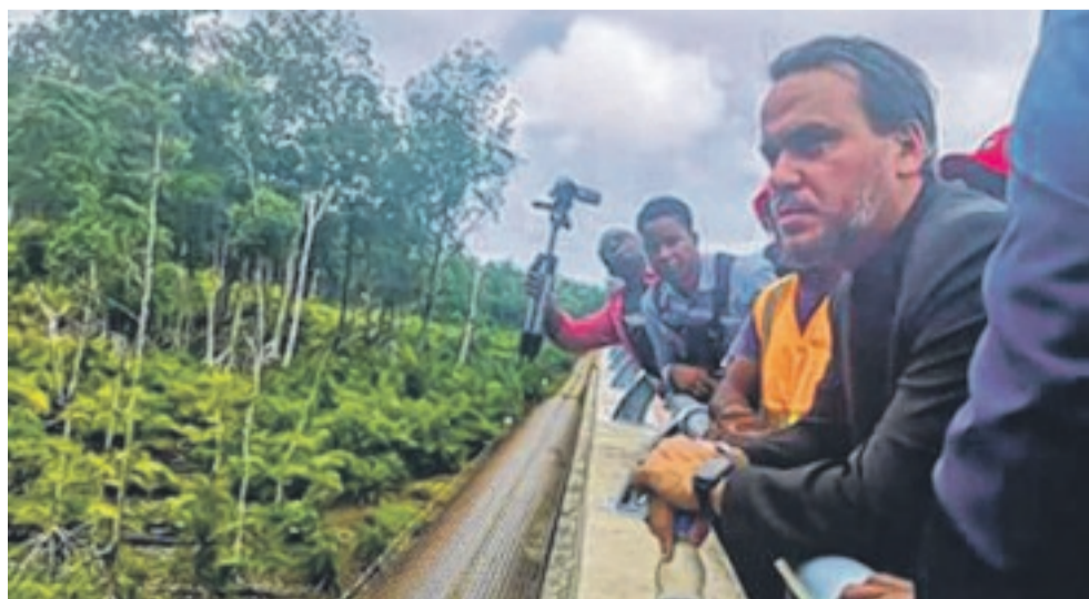
Brice Laccruche Alihanga a pu apprécier l'état d'avancement de la construction du pont d'Ozouri.
