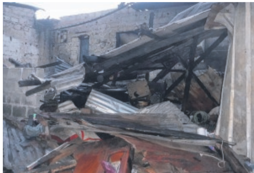
La maison d'habitation a été entièrement consumée par les flammes.
