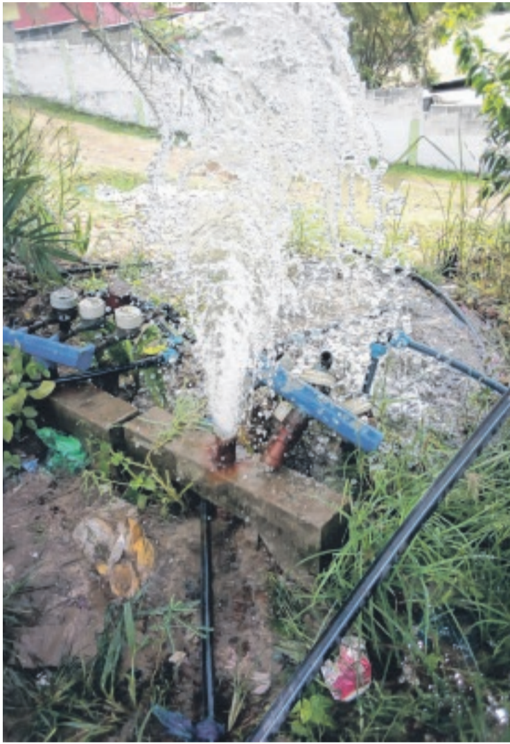
Un dispositif technique d'adduction d'eau rompu à Awoungou.
