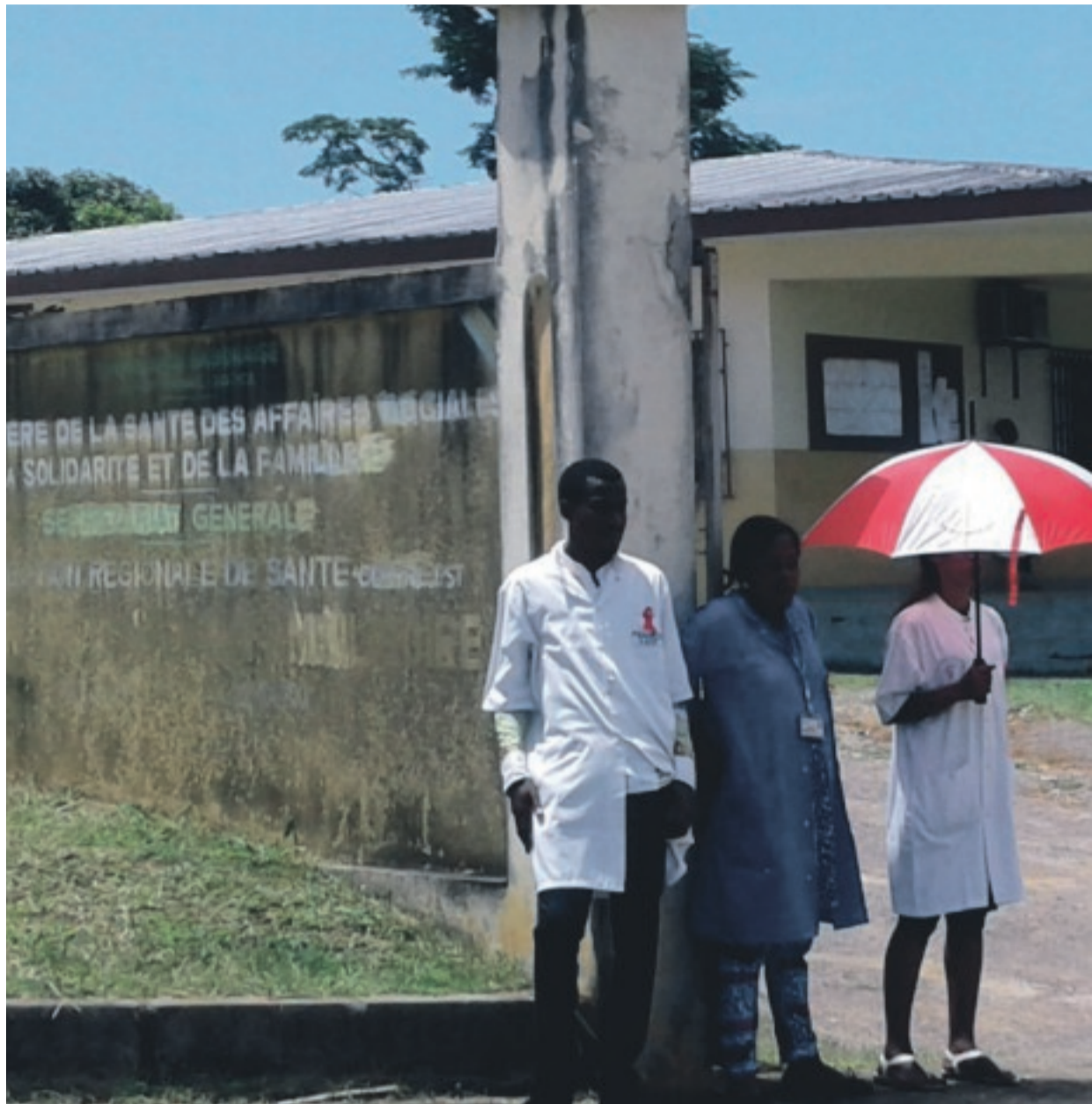
L'entrée du bâtiment abritant le CTA de Koula-Moutou : la structure est devenue exiguë.
