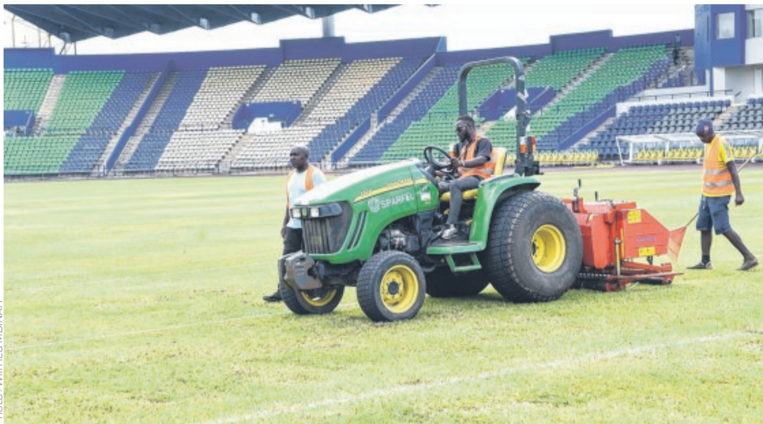
Les travaux se poursuivent au stade de Franceville, qui abritera ce dimanche la rencontre Gabon-Angola.
