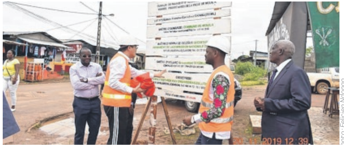
Lancement des travaux pour le pavage des voies à Mouila.
