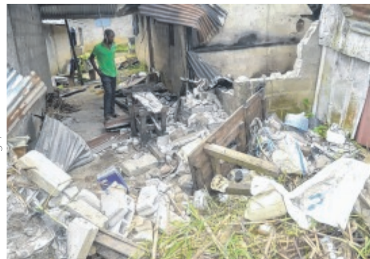
Ce qui reste de l'habitation de Mikolo après l'incendie.
