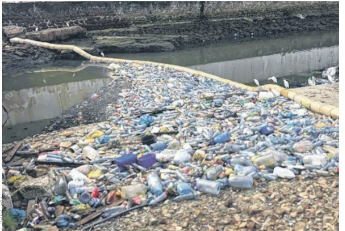
Photo : DR Le filet de rétention des ordures fabriqué à base de bidons : une solution imaginée par le HCECV.
