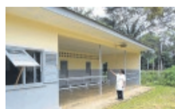
Le dispensaire de Bolossoville, entièrement rénové
