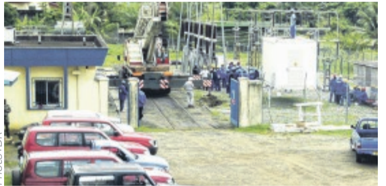
Une équipe de la SEEG sur le terrain pour le rétablissement de l'électricité dans les zones impactées.
