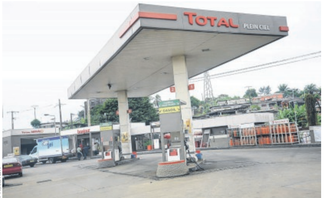
Une station-service Total de Libreville, à Plein-Ciel.
