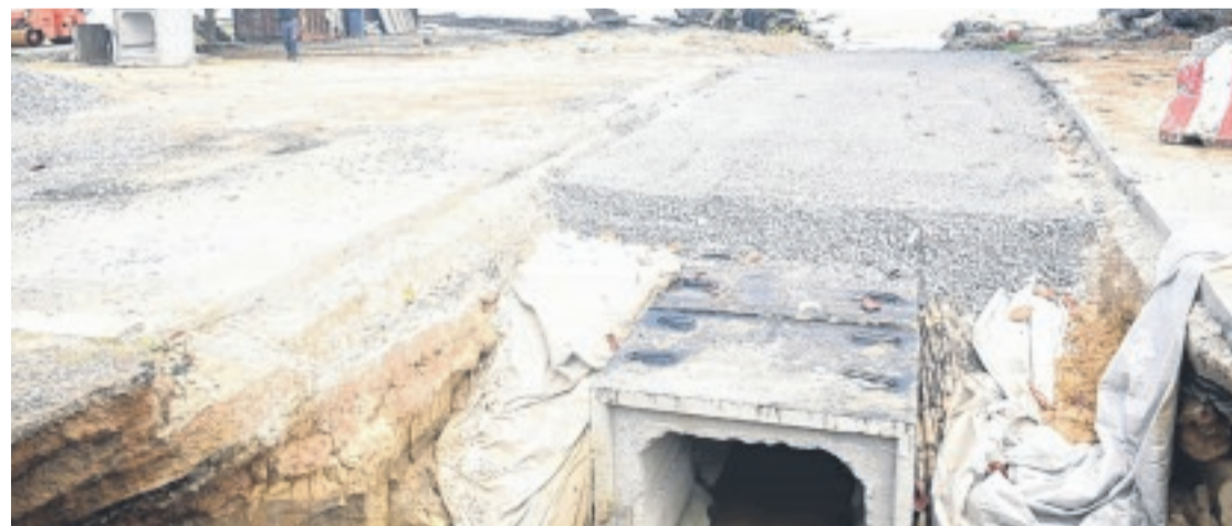
La buse en béton armé dont la réalisation se poursuit, en dépit de la crise sanitaire.
