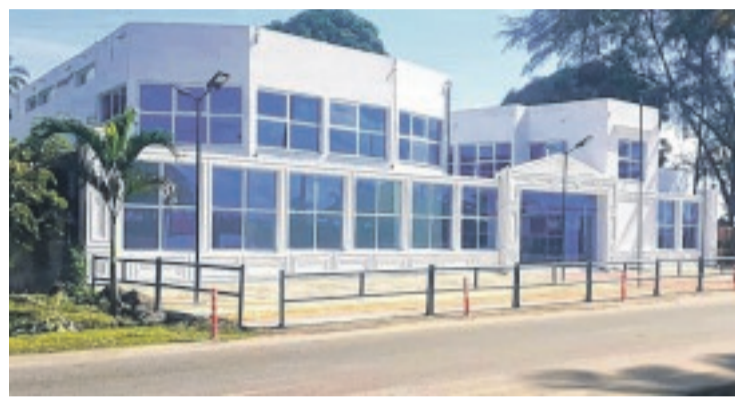
Vue du lycée international d'excellence de Port-Gentil.
