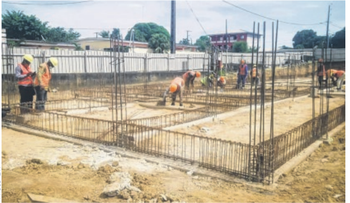
Le bâtiment pédagogique de l'école publique de Mindoubé commence à sortir de terre.
