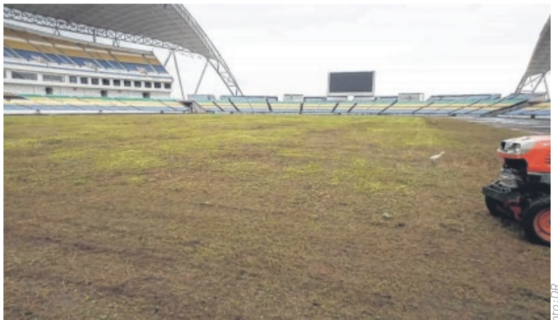
Comme les autres stades du pays, celui de l'Amitié est également en travaux.
