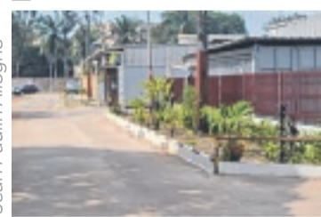
Cette ruelle a été bitumée par un particulier.
