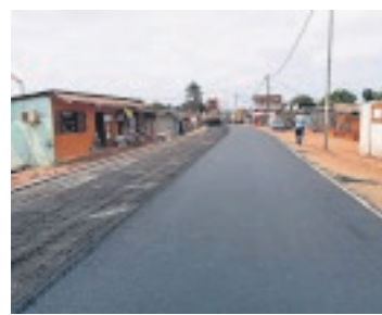
La route Mini-Prix/Sibi entièrement réhabilitée.
