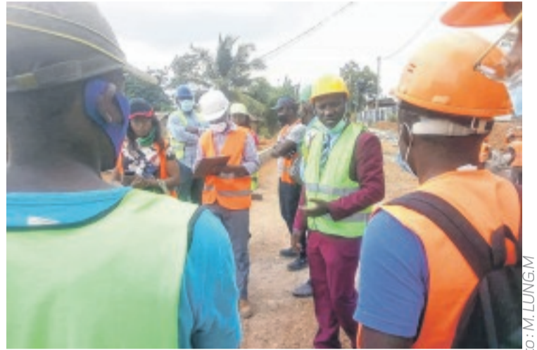
Photo: M. LUNGUM Le chef de mission de la CNTIPPE, Mabike Ma Iwangou, sur un des chantiers de pavage.
