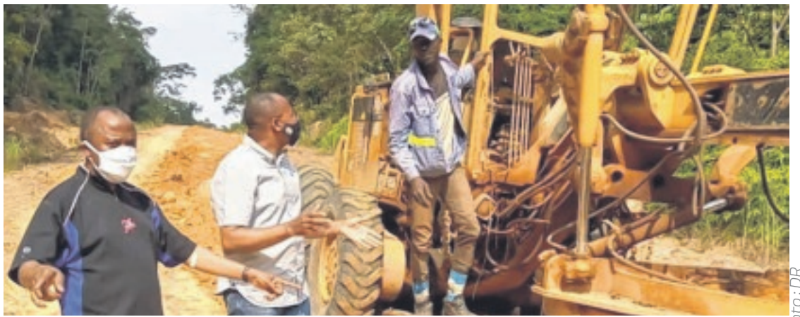
Les travaux ont bel et bien repris sur l'axe Alanga-Aboumi.
