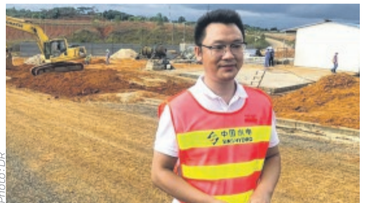
Photo: DR M. Chen Zhijian, représentant Sinohydro Gabon. En arrière plan, les travaux préparatoires.
