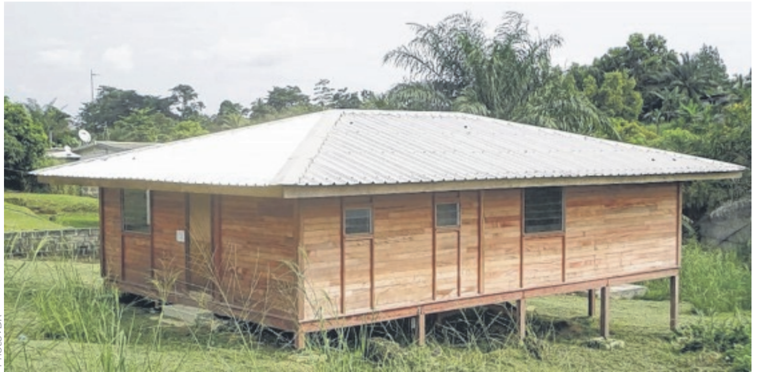
C'est ce modèle d'habitation qui est en construction au village Elarmilo.
