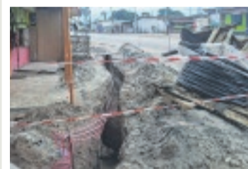
Vue des travaux de renouvellement de la liaison.
