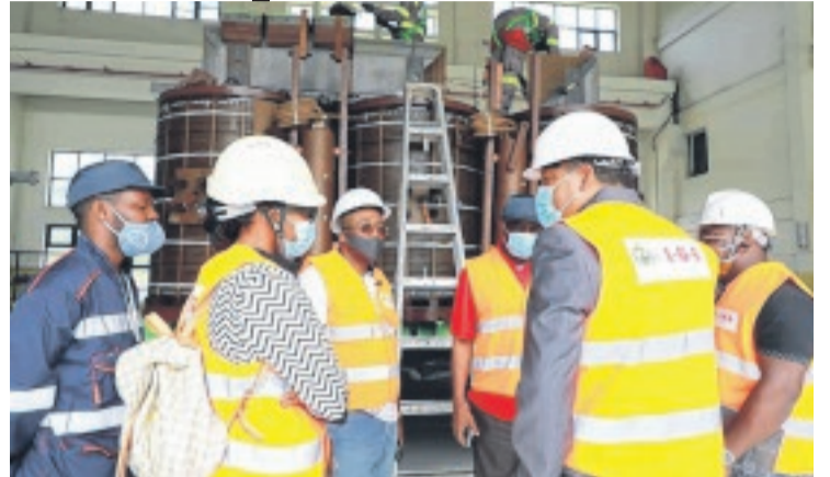
Séverin Mayounou à la faveur de la visite de l'infrastructure.
