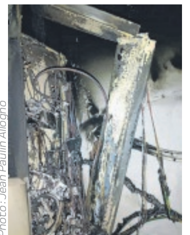
Le compteur électrique calciné.
